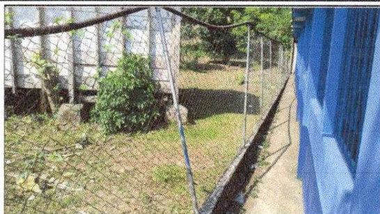
FOTO 7: Reparación de muro perimetral de block con tubo hg y malla galvanizada, soleras intermedias y columnas.
