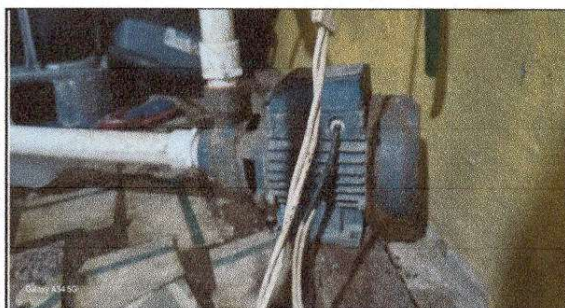
FOTO 3: Sustitución de bomba de agua
