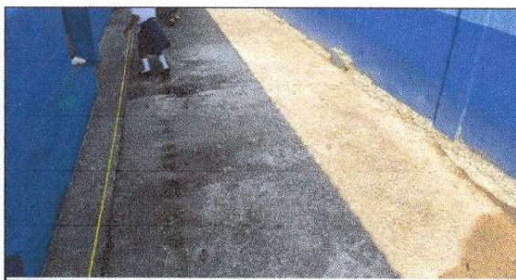
FOTO 5 ; Sustitución de piso cerámico
