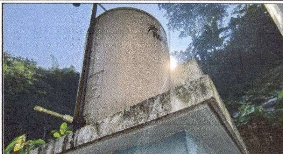
FOTO 2: Sustitución de depósito de agua 1100 lt
