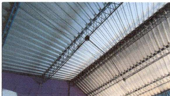
FOTO 9: Sustitución de focos ahorradores, instalación de unidades luz (incluye interruptor, ducto y cable eléctrico)
