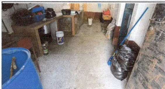
FOTO 1: Sustitución de piso cerámico
